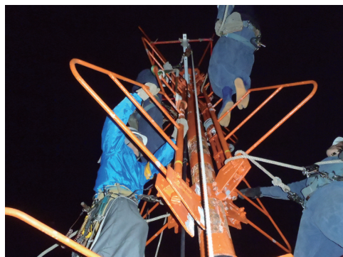
写真3 深夜、余震のある中での復旧作業
